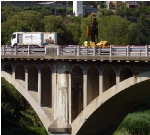
Operaris fent sondejos al pont per analitzar l'estat del viaducte, el juny de 2006. Foto: R. E.
