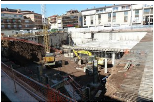
Una vista general de les obres de construcció de la nova plaça Mercat d'Olot. Foto: J.C.
