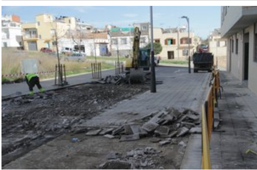
Feines per arrencar les peces de formigó del paviment malmès del carrer de Montserrat Roig, divendres, a Sant Feliu Foto: E.A.
