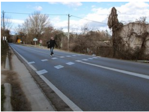
El tram on es farà el túnel a l'N-141. A la dreta, l'antiga rajoleria que s'enderrocarà Foto: J.N.
