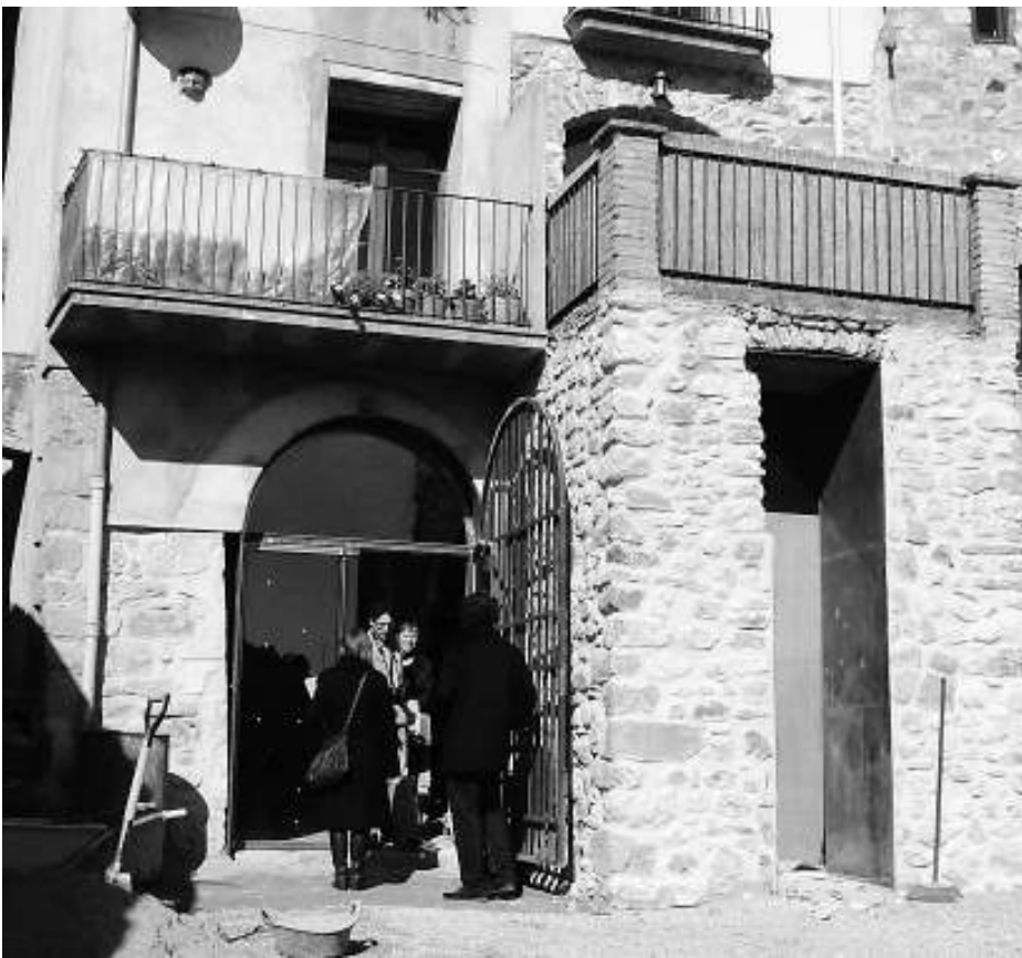
Exterior del nou equipament -encara en obres- ahir al matí. / R.E.
