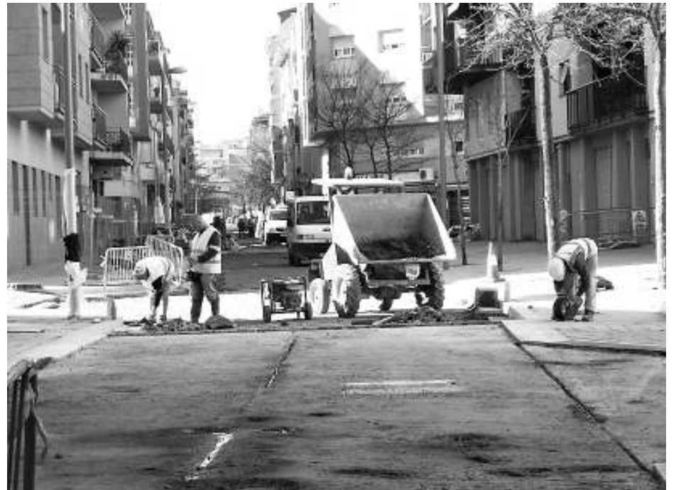
Diversos operaris treballant al carrer Maçana, on s'està acabant el primer tram. / D.V.
