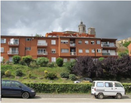
Blocs de pisos a l'entrada de Llagostera Foto: J.N.
