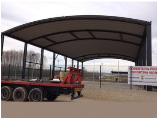
La pista esportiva de Vidreres, que s'ha refet, compta ja amb una coberta. Foto: EL PUNT AVUI.
