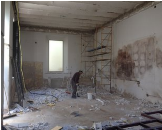
Obres a l'interior de l'antiga biblioteca, ubicada a la planta baixa de la casa consistorial de Vidreres, per instal·lar-hi els jutjats de pau. Foto: EL PUNT AVUI.
