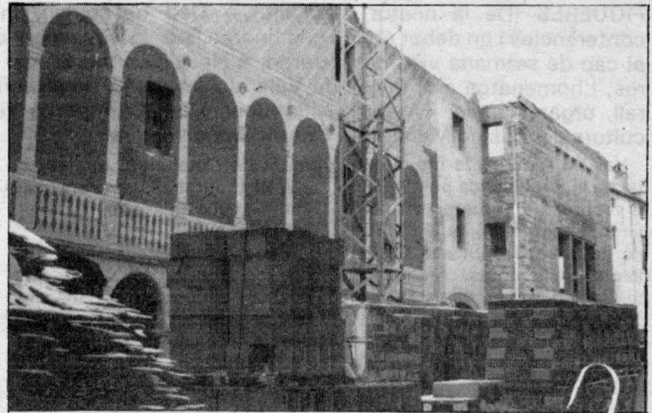
La primera fase de les obres al Convent de Sant Domènec de Puigcerdà comencaren el juliol del 1.985.
