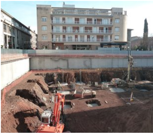
Un detall de les obres. Foto: J.C..
