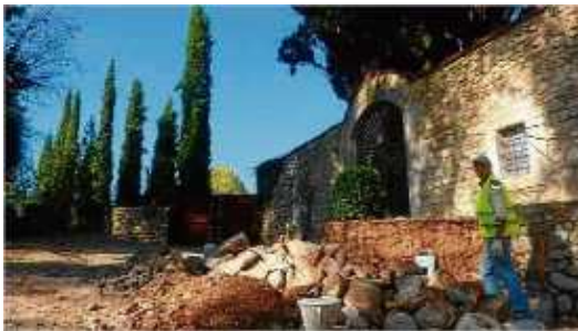
Obres de millora al recinte mortuori de Besalú.
