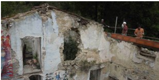
Paletes treballant en el cinturó superior al cap de poc de començar les obres. Foto: JOSEP VILAR.
