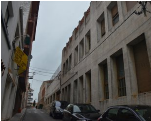
Edifici de Ca les Monges, comprat per l'ajuntament de l'Escala al Bisbat i que aquest any anirà a terra. Foto: EL PUNT AVUI.
