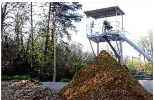
Planta de compostatge de la cooperativa la Fageda.
