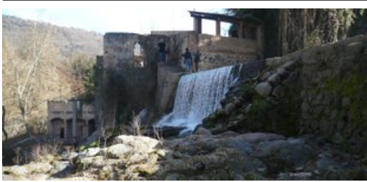
La resclosa del Molí Fondo de Sant Joan les Fonts, una de les més emblemàtiques del Fluvià garrotxí, generava energia a una paperera. Foto: J.C.
