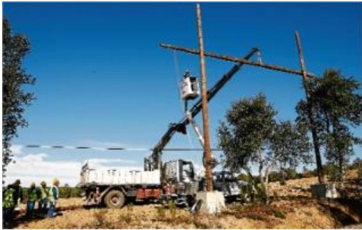
Operaris d'Endesa treballant ahir en la restitució de les torres elèctriques, allunyant-les de Can Vidal.
