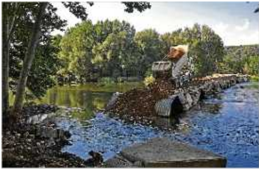
Tram final de les obres a la passera de Bescanó a Sant Gregori.
