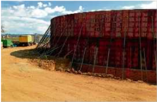
Les obres del dipòsit de 2.000 m 3 a Llagostera avancen.
