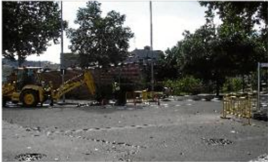
Actuació al carrer Joan Fuster, amb maquinària i operaris.
