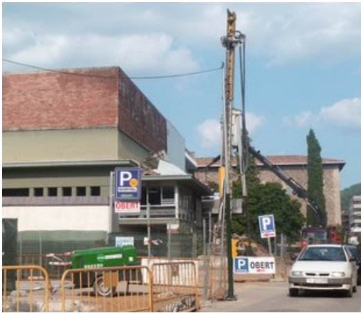
La plaça Mercat, en obres. Foto: J.C..
