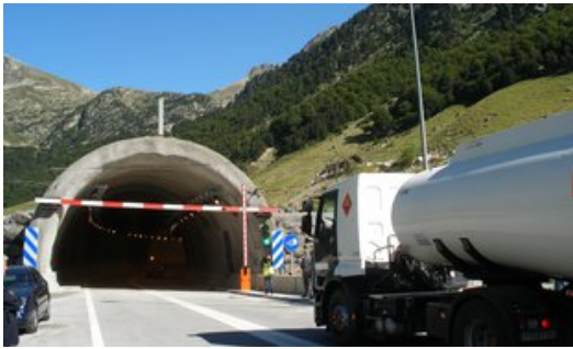
L'únic radar per tram es troba al túnel de Vielha Foto: ARXIU.
