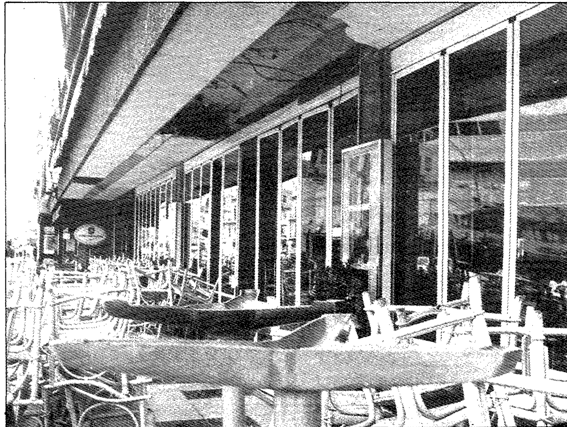
A la part superior de la fotografia es poden veure els danys que va patir l'establiment com a conseqüència de l'explosió de gas. Foto: Lluís Serrat.
