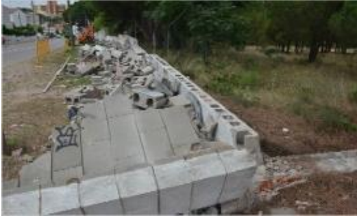
La delimitació de formigó que l'Ajuntament està enderrocant.
