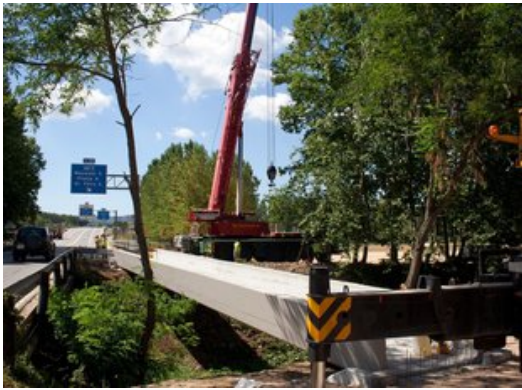
Màquines descarregant la peça de formigó de 30 metres i 57 tones de pes. Foto: EL PUNT AVUI.
