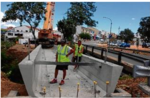
Vidreres instal·la una passera al pont del Rec Clar
