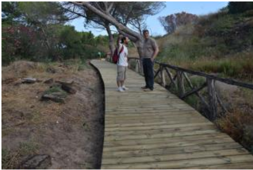
La passera de fusta ha estat renovada.
