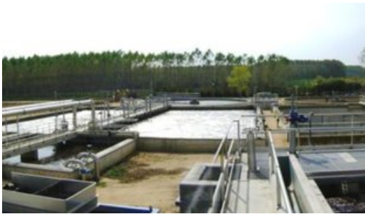
La depuradora Sils-Vidreres s'acaba d'ampliar. Foto: AGÈNCIA CATALANA DE L'AIGUA.
