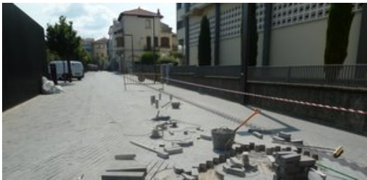
Un detall dels treballs de substitució de llambordes del Firalet d'Olot, ahir al matí. Foto: J.C.
