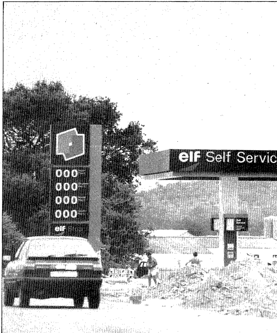
Aspecte de les obres de la nova gasolinera de Vulpellac. Foto: Lluís Vilardell.
