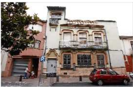
L'edifici Masó es troba al carrer Major i està ocupat per les entitats.
