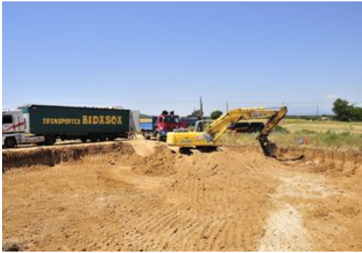
Les obres per fer el nou dipòsit a Mas Pinet Foto: EL PUNT AVUI.
