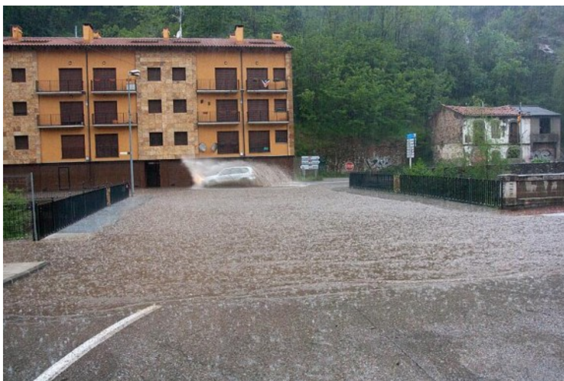
Acumulació d'aigua al pont de la Lletona de Ribes. Foto: Laia Deler
