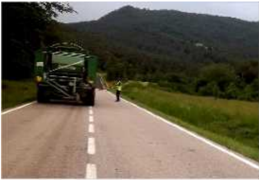
Milloren la carretera de Porqueres a St. Miquel
