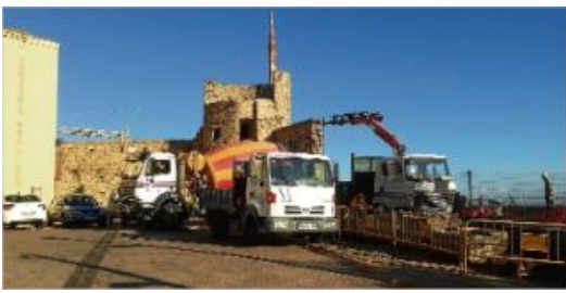
Acaba la segona fase d'obres a la muralla de Llagostera
