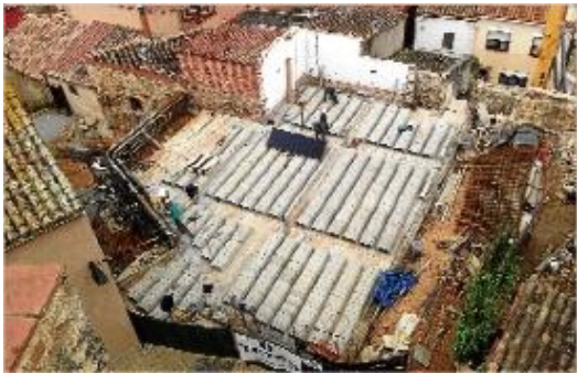
Actualment s'està treballant en el sostre del centre.
