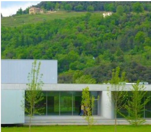
Detall de la façana principal del nou centre hospitalari, pràcticament acabat. Foto: R. E.
