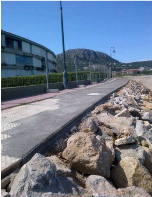
El passeig, després que la brigada hagi formigonat el ferm esllavissat Foto: EL PUNT AVUI.
