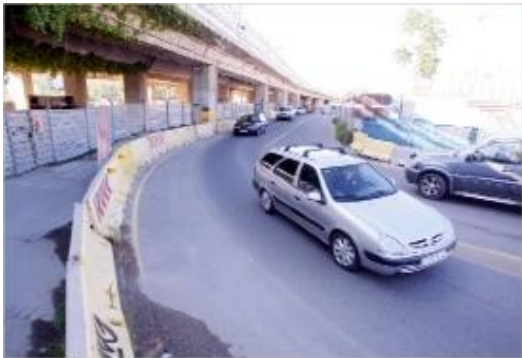
El tram que Adif s'ha compromès a reparar.
