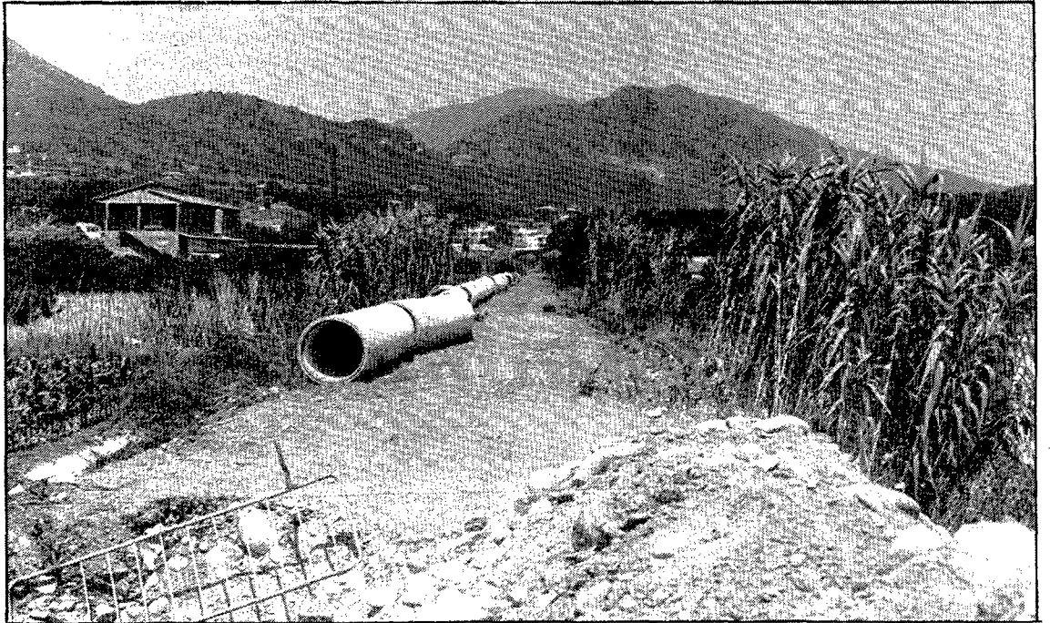
Els tubs que havien de col·locar-se als terrenys de la FEVE han quedat damunt la terra perquè l'Ajuntament de la Cellerera no vol que passin per aquí. (Foto: Mòn del Raval)
