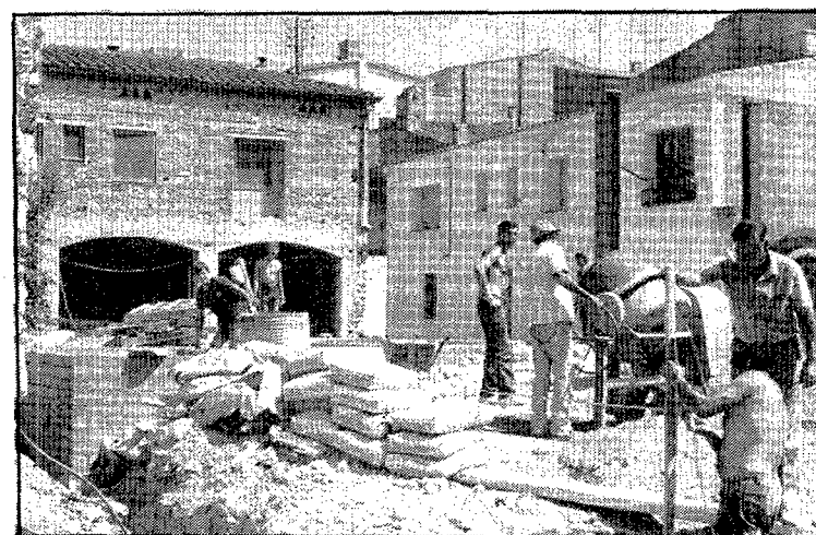
Les obres ja han començat (Foto: Josep Martinoy)
