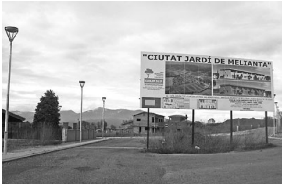
Aspecte parcial de la urbanització, que es construeix en un extrem de Melianta. / R.E.
