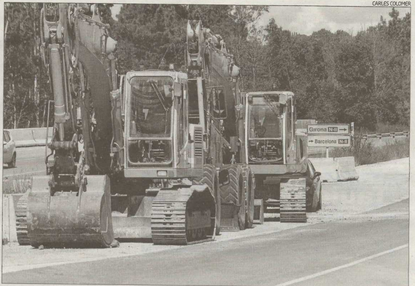
Les màquines van tornar a estar ahir presents per reiniciar el desdoblament de la N-II entre Sils i Caldes.
