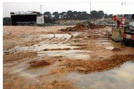
Els terrenys on s'estava fent el moviment de terres entre Sils i Caldes, ahir, convertits en un gran bassal de fang. carles colomer
