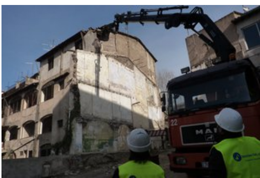
Els començament dels treballs d'enderroc ahir al matí. Foto: R. E.
