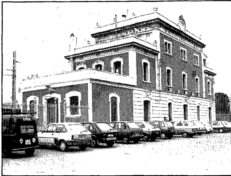
Enher va triar l'estació de Caldes per fer pressió a Renfe reclamant el pagament de nou-cents milions de pessetes. (Foto PABLITO JR).
