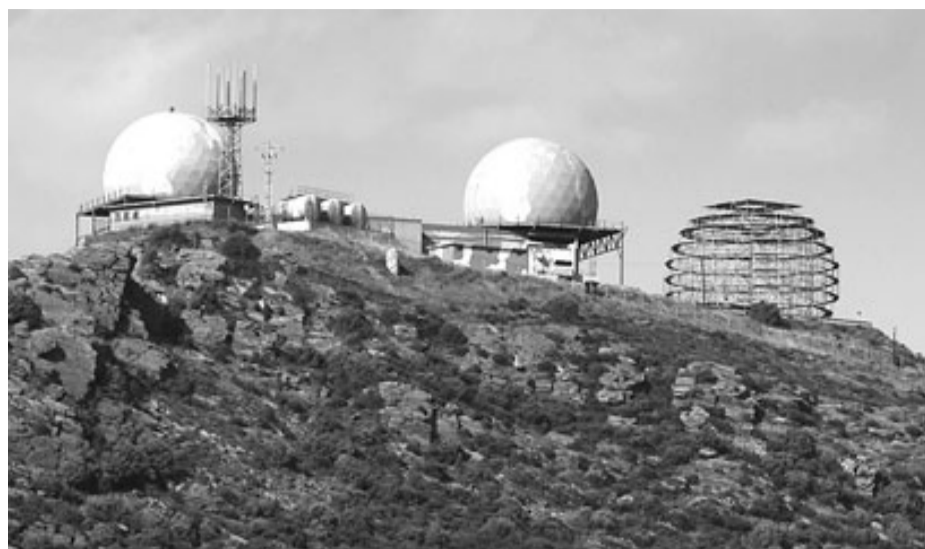
L'estructura metàl·lica de la nova esfera, al costat de les «boles» del Pení. / LLUÍS SERRAT
