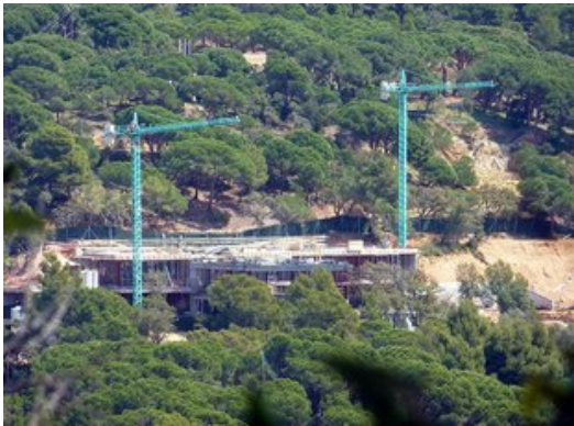
Imatge de les polèmiques obres a Can Juncadella que han estat denunciades per SOS Lloret. Foto: EL PUNT AVUI.
