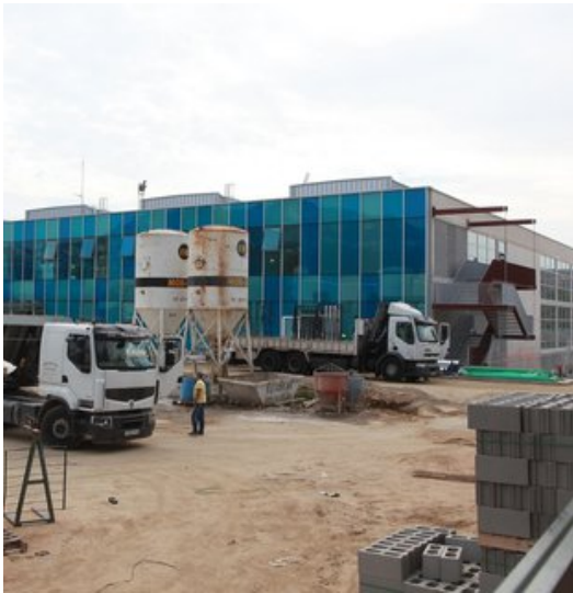
La piscina de Lloret, en obres l'octubre passat. Foto: J. SABATER.
