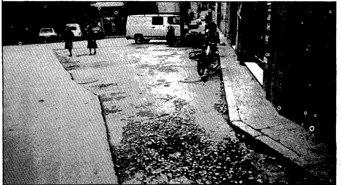
Abans de finals d'any començaran a Caldes les obres per fer desaparèixer la imatge dels carrers a mig asfaltar. (Foto CARLOS SANS).
