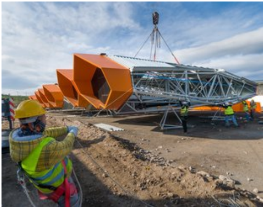
Les obres de construcció de la sortida de Fornells. Foto: ABERTIS.
